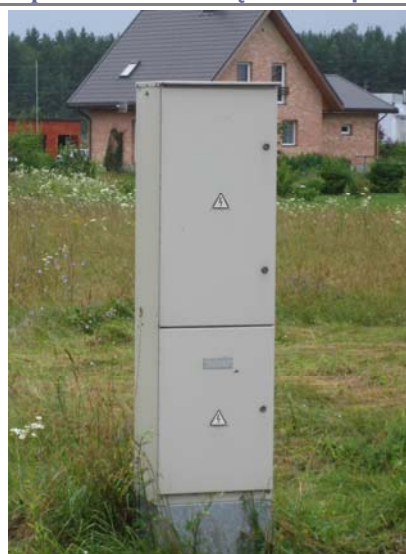
1 pav. Elektros įvadinė spinta
